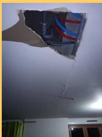
Remplacement du ballon solaire de production d'eau chaude et réparation du plafond suite à dégâts des eaux.
